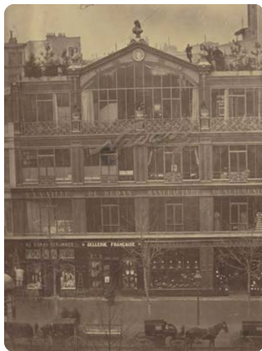
Atelier de Nadar au 35, boulevard des Capucines à Paris, Nadar
